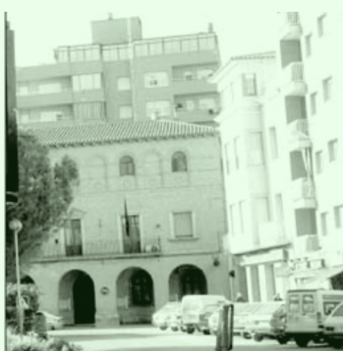
Edificio que será derribado. JLR
