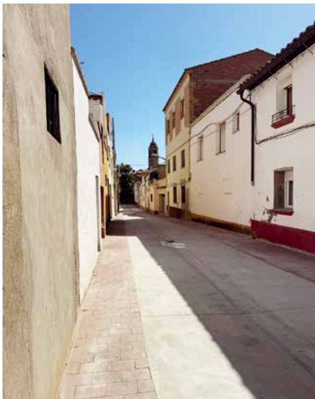
Imagen de la renovación realizada en la calle Guilleuma
