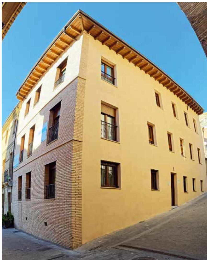
Imagen del nuevo edificio con 7 viviendas para alquiler social
