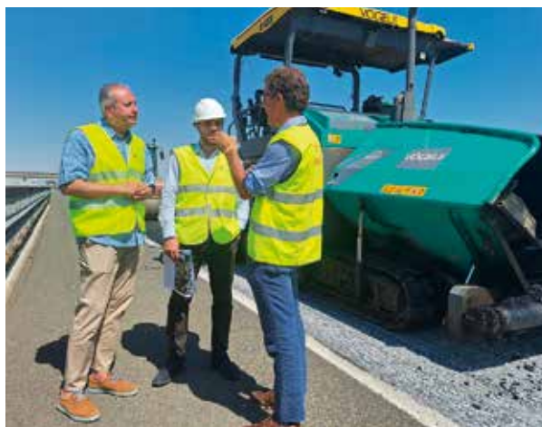
Imagen de la visita del subdelegado a las obras de la A-22
