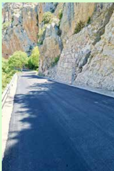
La carretera ha estado cortada tres meses y medio
