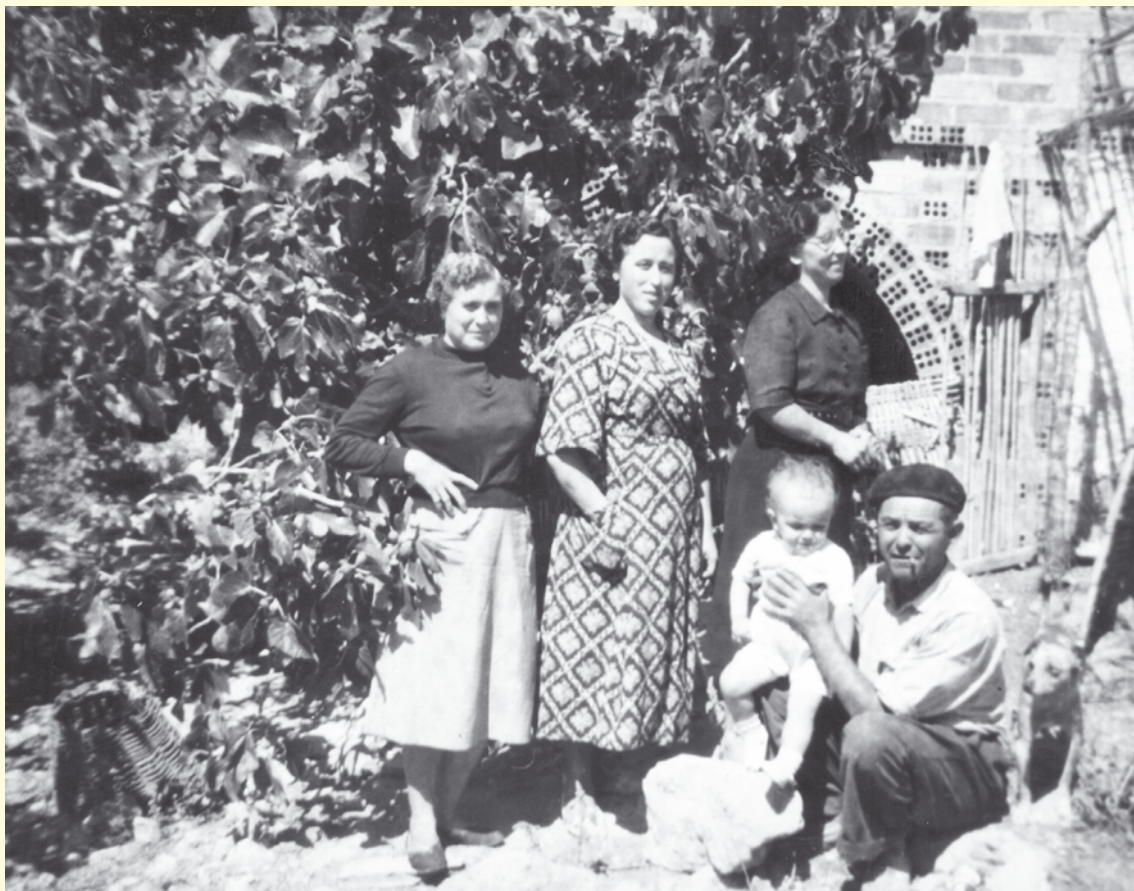
Familia Angosto, en Albelda, junto a la torre que estaban construyendo
