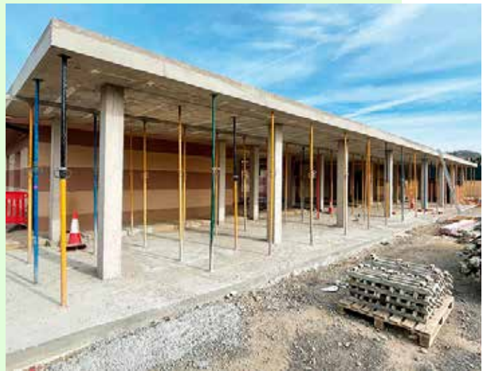
Las obras de ampliación siguen en marcha en La Sabina
