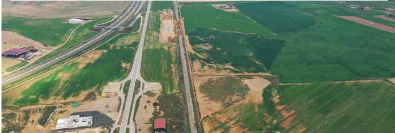
Imagen aérea de los terrenos (dcha.) que acogerán la futura plataforma logística
